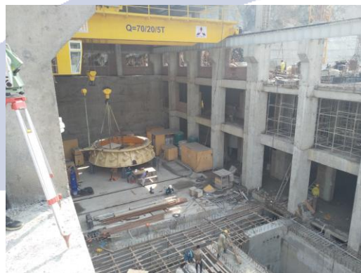
(Hình ảnh: Lắp đặt tuabin TĐ Bảo Nhai 2, đã phát điện 2022)
