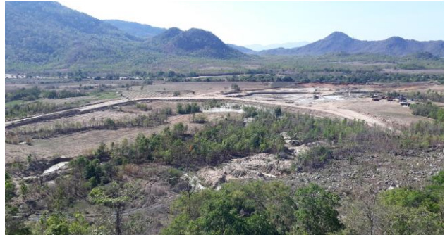
(Hình ảnh: Kênh xả và đê bao bảo vệ nhà máy thủy điện tích năng Phước Hòa – nằm trong hồ Sông Cái)
