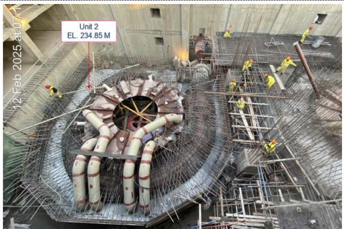
(Hình ảnh: Lắp đặt tuabin TĐ Nậm Phak thời điểm tháng 02/2025)
