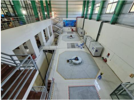
(Hình ảnh: Lắp đặt tuabin TĐ Suối Sập 2A, đã phát điện 2022)
