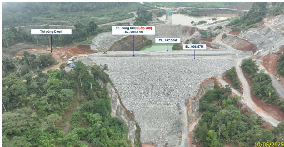
(Hình ảnh: Đập Phou Pong, H_{max}=60.5m thời điểm tháng 05/2025)
