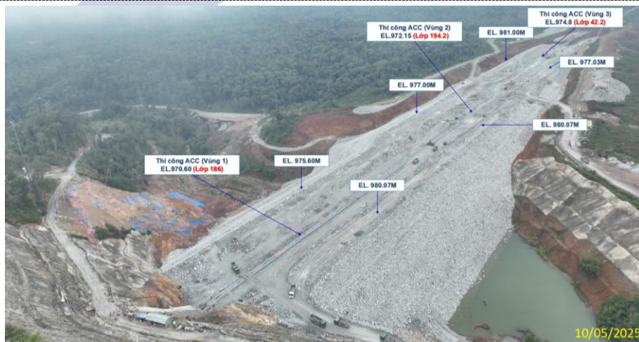
(Hình ảnh: Đập Nậm Pha, H_{max}=76.6m thời điểm tháng 05/2025)
